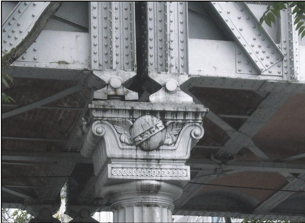
Photo.1. - Appui mobile (gauche) et fixe (droite), pont du métro de Paris.
