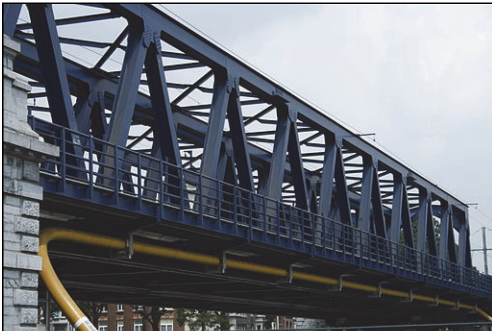
Photo.4. - Poutre en treillis : Pont de Namur.
