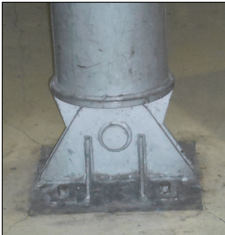
Photo.2. - Appui fixe (articulation), gare du Nord Paris.
