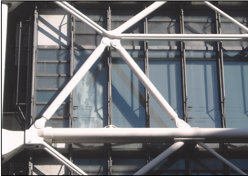
Photo.3. - Barres bi-articulées du centre Georges Pompidou à Paris.
